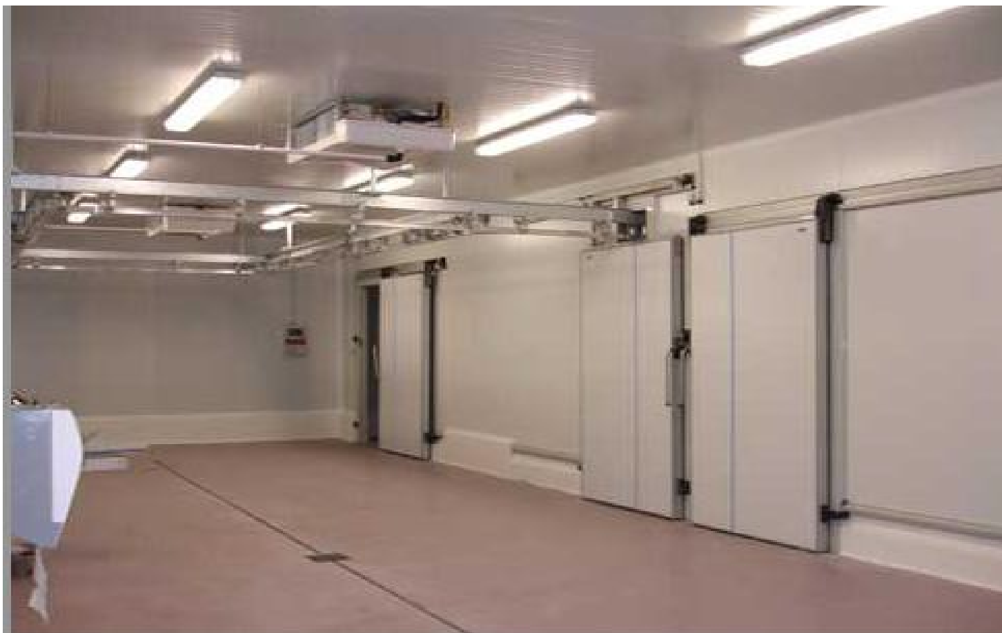
Paneles para sala de despiece
